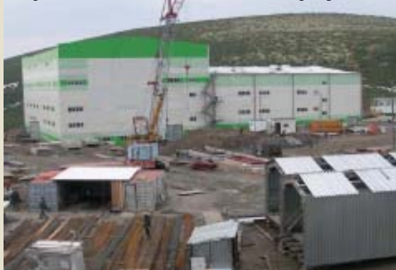
Строительство главного корпуса
